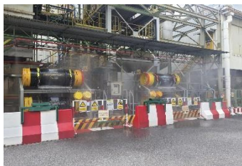
ภาพที่ 4 DeNOx Technician ทำการปิด Shutter B&C และทำการเปิดม่านน้ำ เพื่อลดการฟุ้งกระจายของ Ammonia ระหว่างรอ NPC เข้าระงับเหตุ
