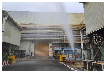
ภาพที่ 5 DeNOx Technician ทำการปิด Fix monitor A&B ลดการฟุ้งกระจายของ Ammonia ระหว่างรอ NPC เข้าระงับเหตุ
