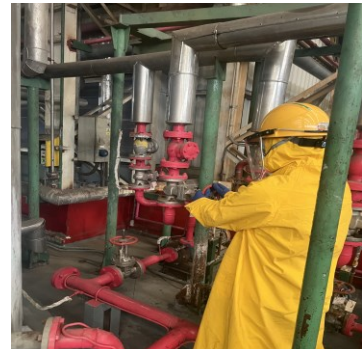
รูปที่ 6 พนักงานทำการปิด Valve ของ Pump
