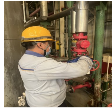
รูปที่ 9 GL ตรวจสอบและ MT แก๊สจุกรั่ว
